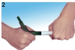
**! CONTROLLARE SE IL TUBO È STATO INSERITO TOTALMENTE**
